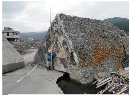
大槌の防潮堤の被災状況（天端高5m）
