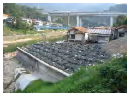
市街地における仮設護岸としての使用例。
