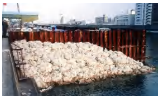
阪神大震災を始め、数多くの災害復旧工事の採用実績あり。
