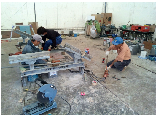
気仙沼仮設修理場
